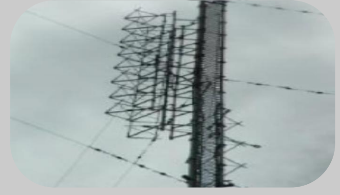
เสาอากาศ
